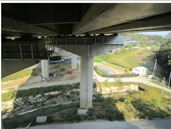
교량 하부 전경
