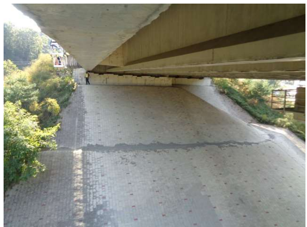
교량 하부 전경
