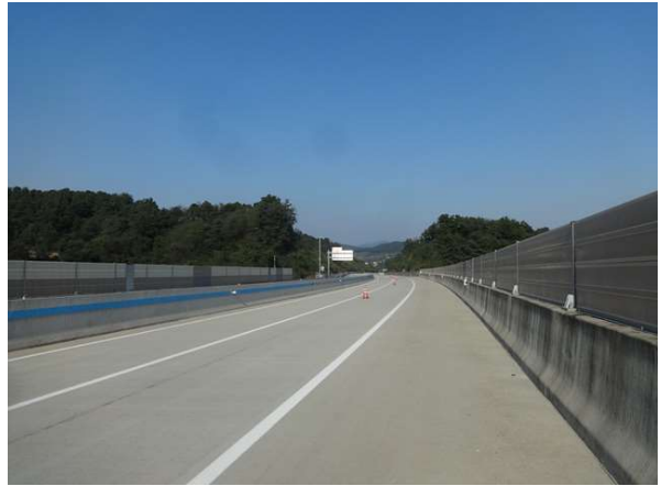
교량 상부 전경
