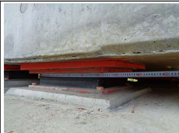
현황 받침 이동량 측정
