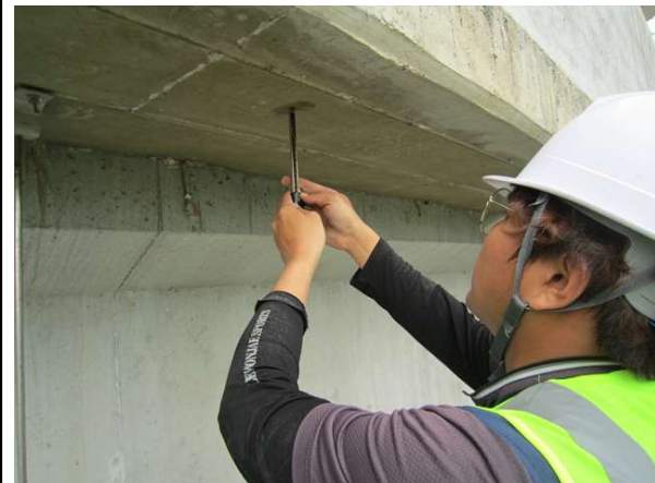
현황 탄산화깊이 측정
