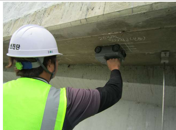
현황 철근탐사 및 피복 측정
