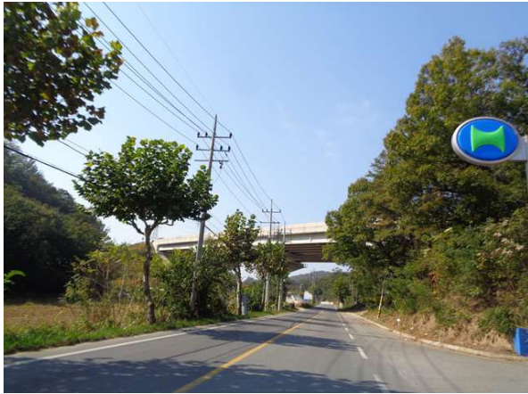
교량 측면 전경
