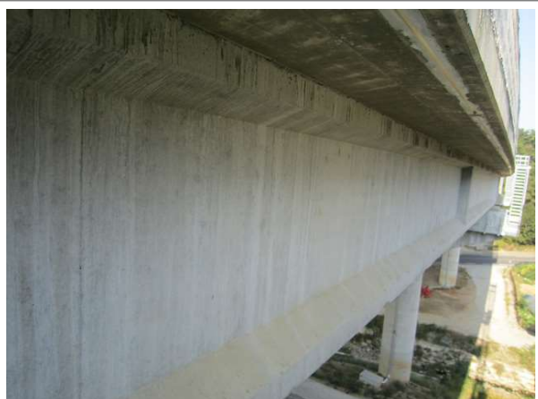
교량 거더 전경
